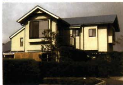
▲住環境の改善を図るため、築15年の戸建て住宅の屋根、外壁にガイナを塗布。
